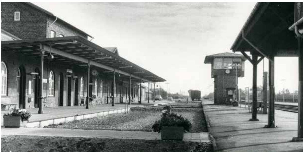
Bramming banegård under udskiftningen af sporareal til bilparkering foran stationsbygningen.
